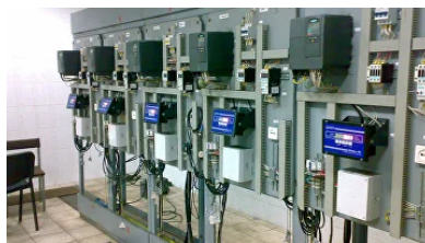
Щитовой вариант монтажа электроники дозаторов непрерывного действия КЛИМ-ВД
